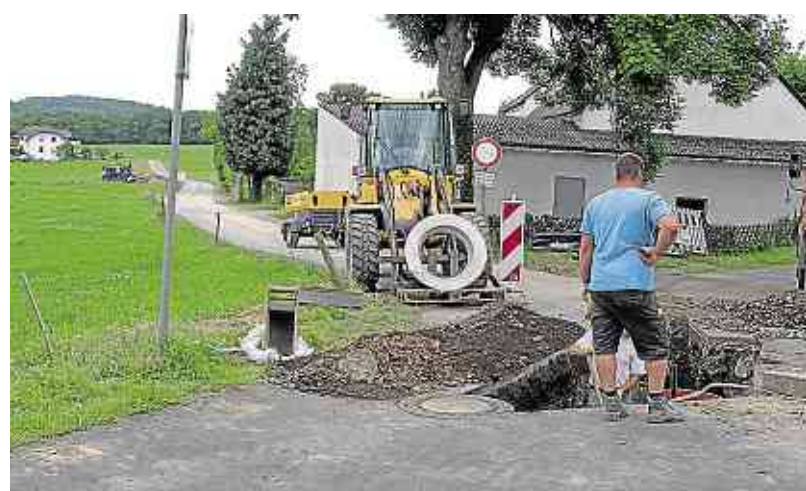
Die Siedlung „Rosenhof“ wird an die Kanalisation angeschlossen. Foto: Puth
